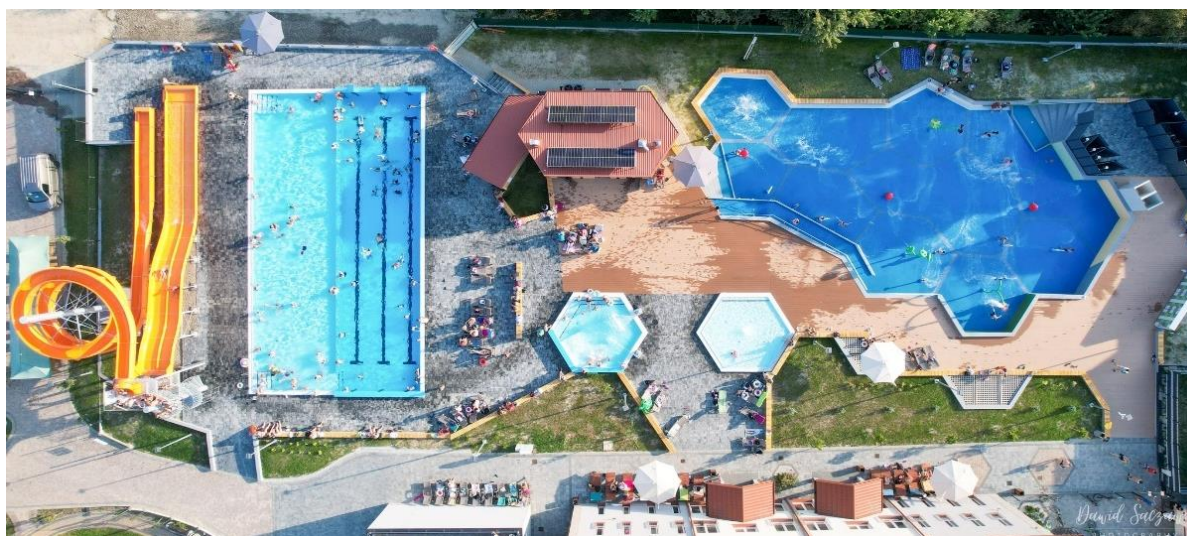
Fot. Kompleks basenów w m. Kamień (źródło: https://www.facebook.com/gm.kamien/?locale=pl_PL )
