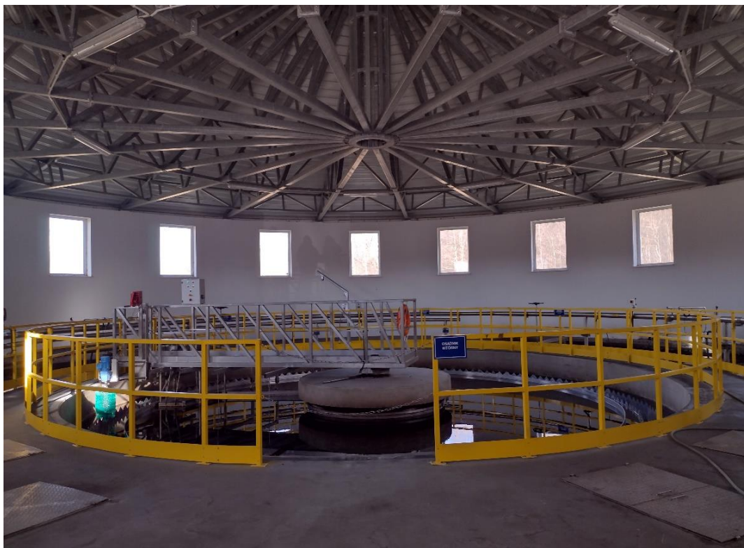
Fot. Budynek oczyszczalni ścieków
