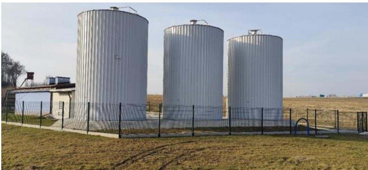
Fot. Zbiorniki wodociągu Świlcza
