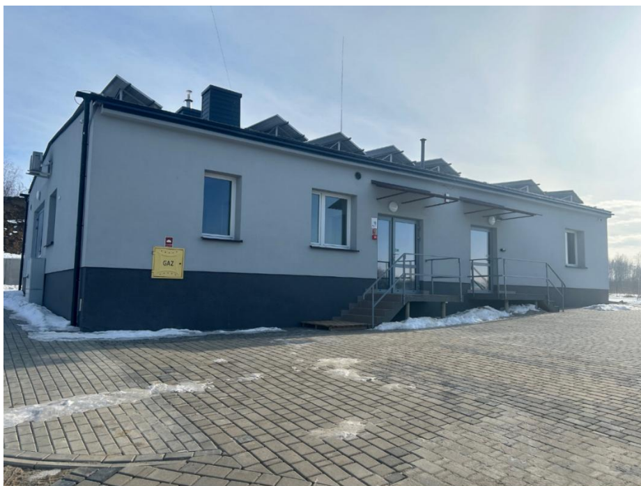
Fot. Budynek Stacji Uzdatniania Wody w Krasnem (źródło: Zakład Usług Komunalnych w Krasnem)
