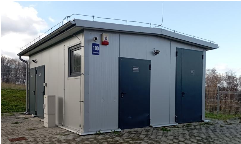
Fot. Budynek Stacji Uzdatniania Wody Rzeszów ul. Podleśna (źródło: zasoby własne PSSE w Rzeszowie)
